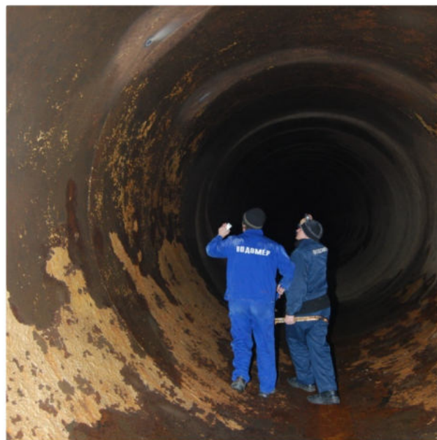
Рис. 1/6 Процесс монтажа расходомеров ИРКА на трубах Ду3600 «Главной насосной станции подачи воды в магистральный канал»
